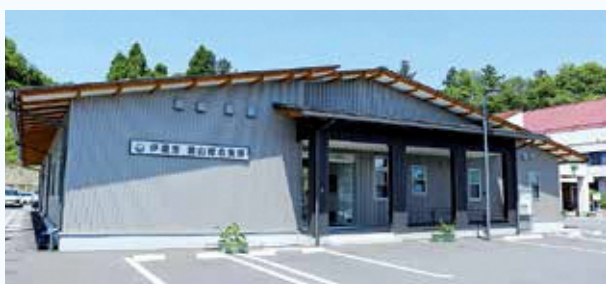
靈山総合支所（外観）
