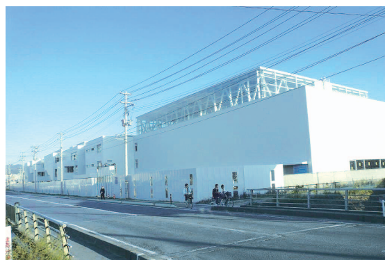
完成が遅れる保原小学校建築工事
