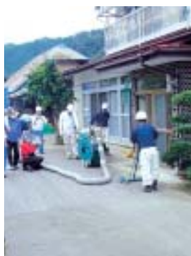
民家除染実証試験（下小国）
