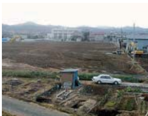
整地が進む梁川小学校建設予定地
