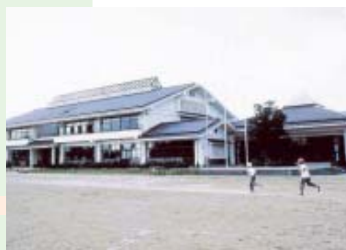
国見町と伊達市で設置している組合立大枝小学校
