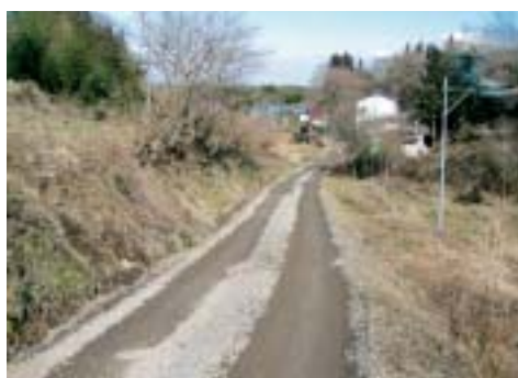
未舗装の生活道路
