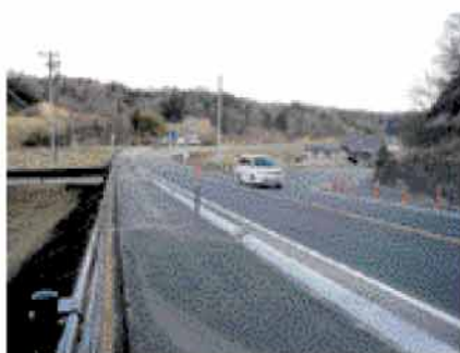
開通した国道115号山戸田バイパス
