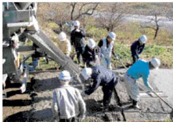
梁川町東大枝地区の現道舗装工事
