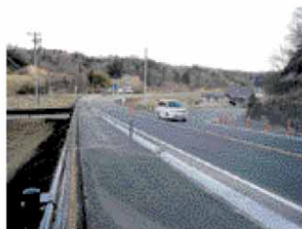
開通した国道115号山戸田バイパス
