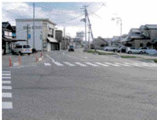
一部改良工事が行われた梁川中央線
