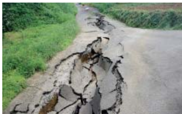
8月29日の局地的大雨による道路災害
