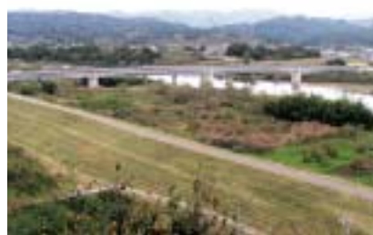
10月15日に開通した梁川大橋
