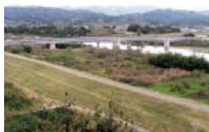
10月15日に開通した梁川大橋
