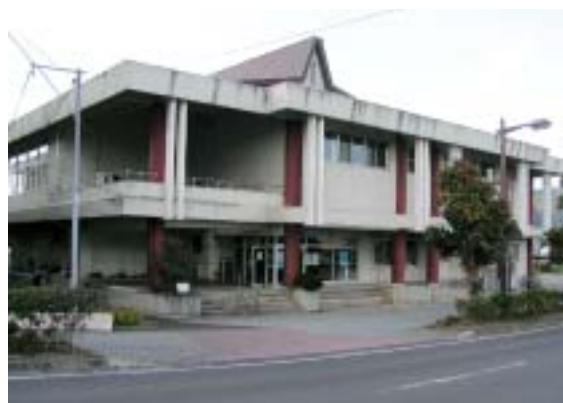
耐震改修実施設計を行う伊達体育館
