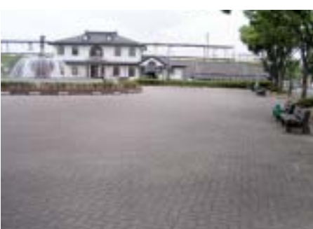
整備工事が予定されている阿武隈急行保原駅
