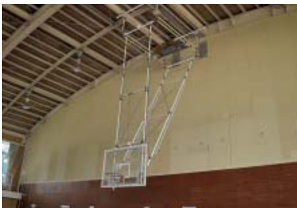
修繕された月館中学校のバスケットゴール
