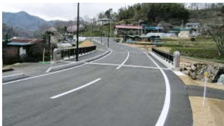
整備された林道館山線・向田橋
