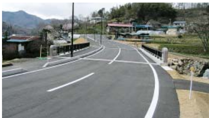
整備された林道館山線・向田橋
