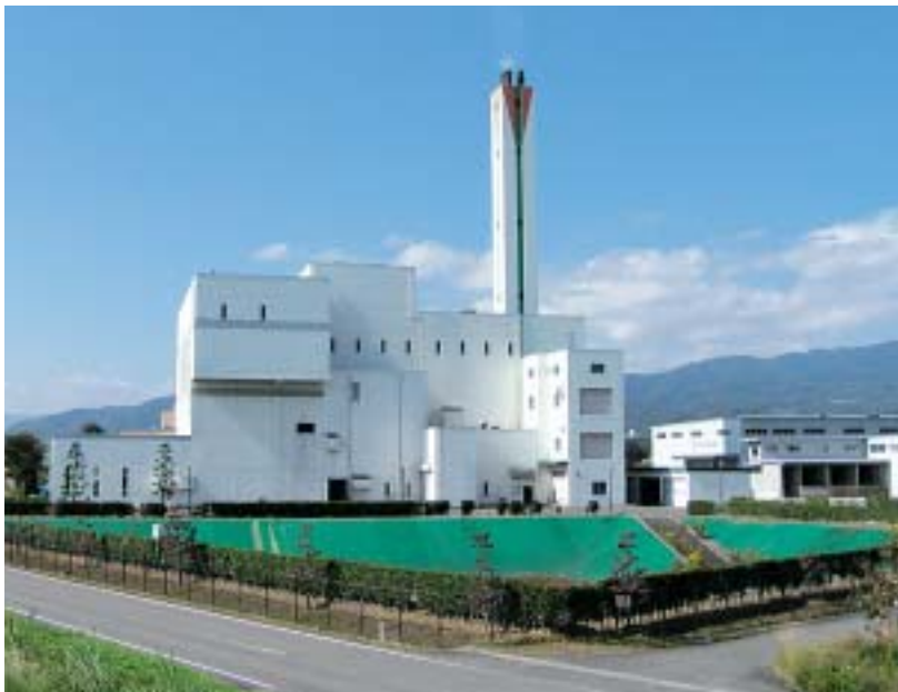
伊達地方衛生処理組合焼却処分場
