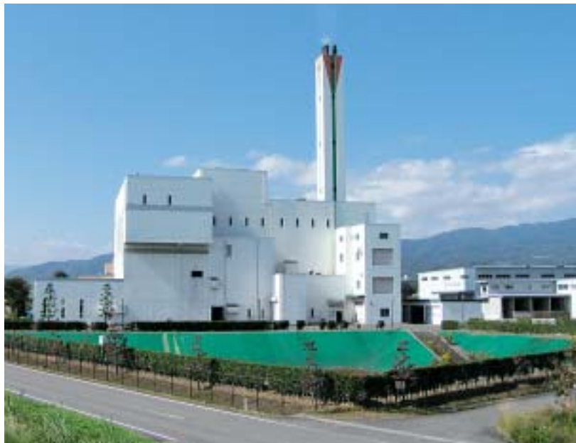
伊達地方衛生処理組合焼却処分場
