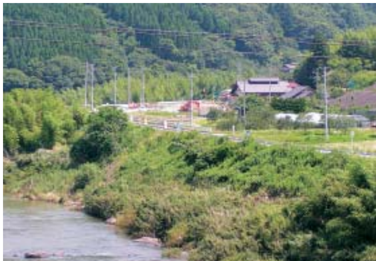
水防災対策特定河川事業により工事が進められている舟生桂野地区(梁川)
