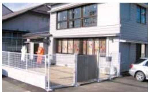
保原町字西町に新設した保原保育園分園
