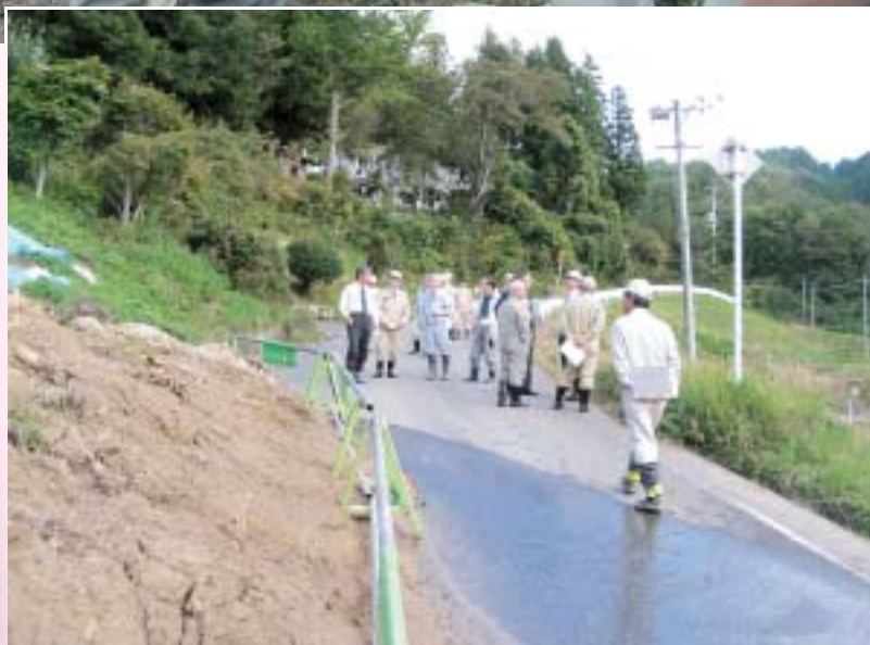
（市道中古屋新田線 月舘町布川字中ノ内地内）
